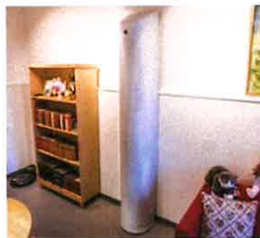
Mobile sløkkeanlegg er utviklet med tanke på å beskytte personer som ikke er i stand til å ta vare på seg selv ved ett branntilfelle. Foto: Oslo Brann- og redningsetat.
